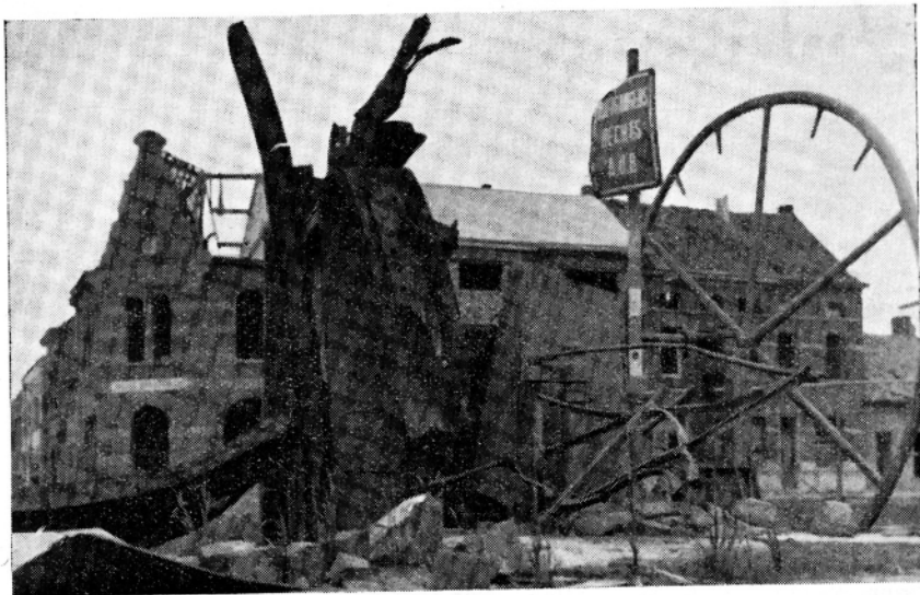
Overschot van de opgeblazen brug op 15 mei 1940 Overkant : Hoek van Mechelse steenweg.
