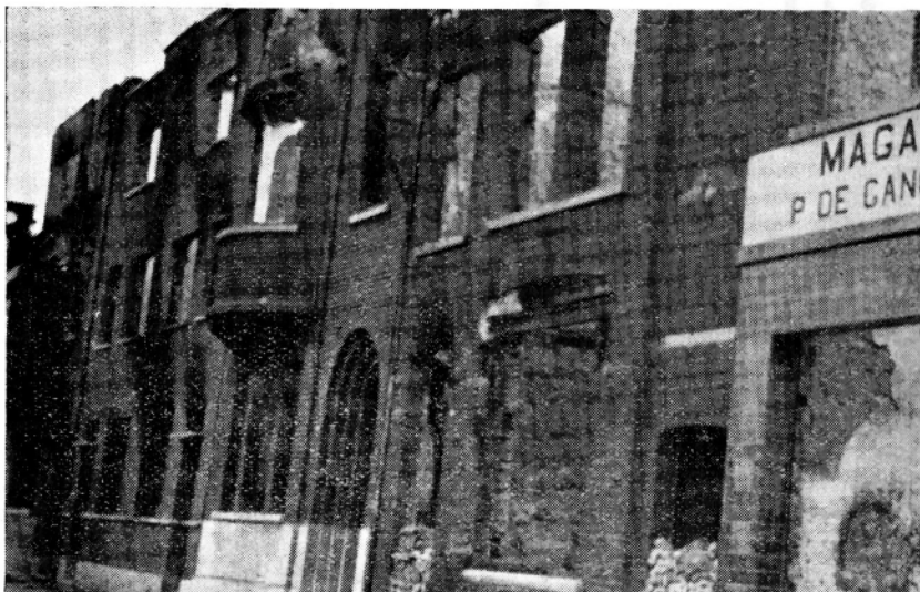
Gedeelte van Westdijk in de nabijheid van de brug.
