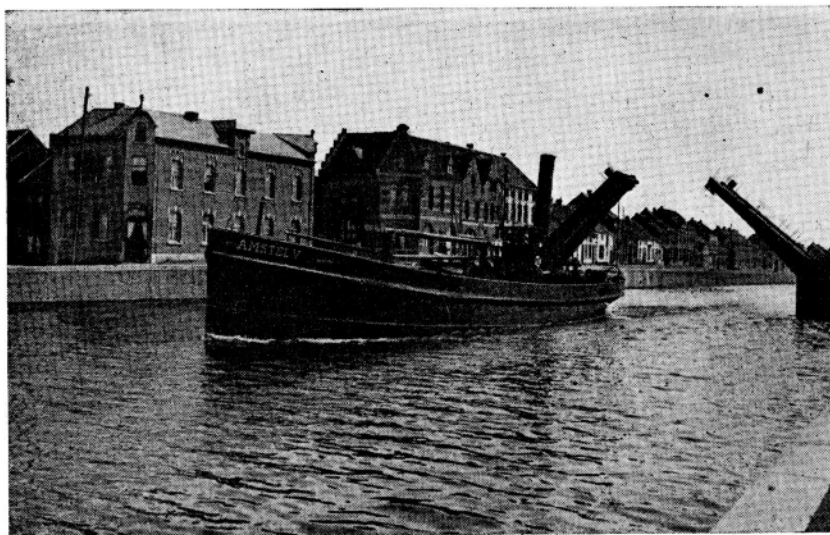
WILLEBROEK — zuidelijke richting — Brug opgeblazen in 1940. Gedeelte waar zich het oude sas bevond (rond 1930).
