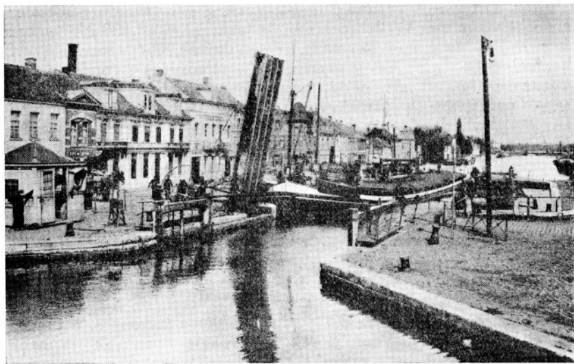
WILLEBROEK — Brug over vaargeul van het Sas, rond 1910. Links: Groot wiel om brug op en neer te draaien met de hand. Rechts: Paal met elektrische verlichting (oud systeem met koolstaven).
