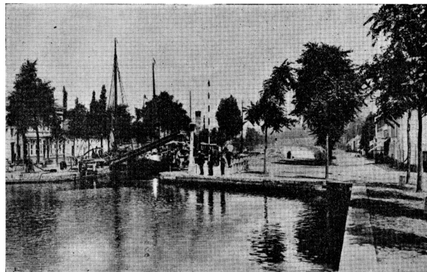
TISSELT — noordelijke richting — Oud Sas (1899) afgebroken rond 1913. (vaargeul met brug) Prentenkabinet (Brussel).
