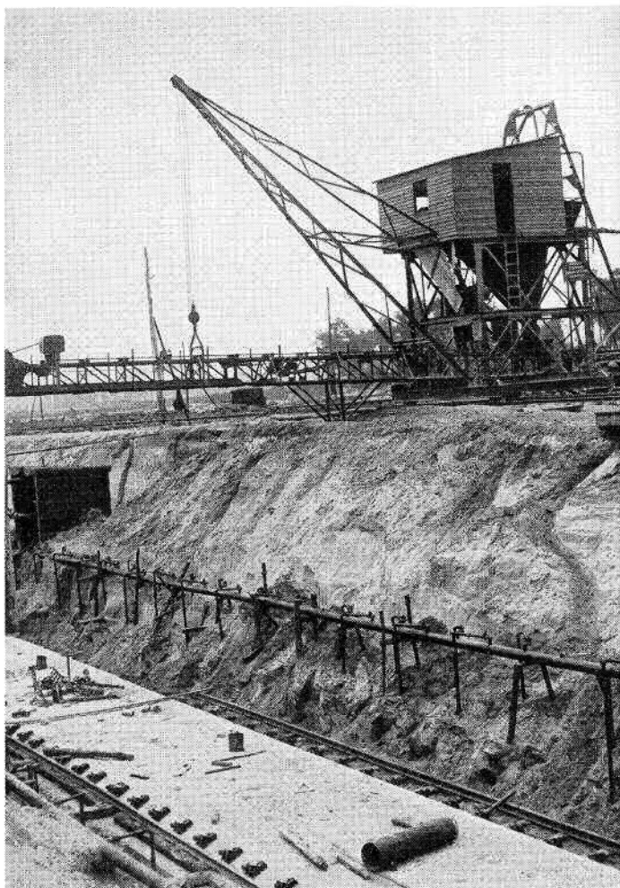
Darse de Genk. Bétonnière et distributeur de béton.
