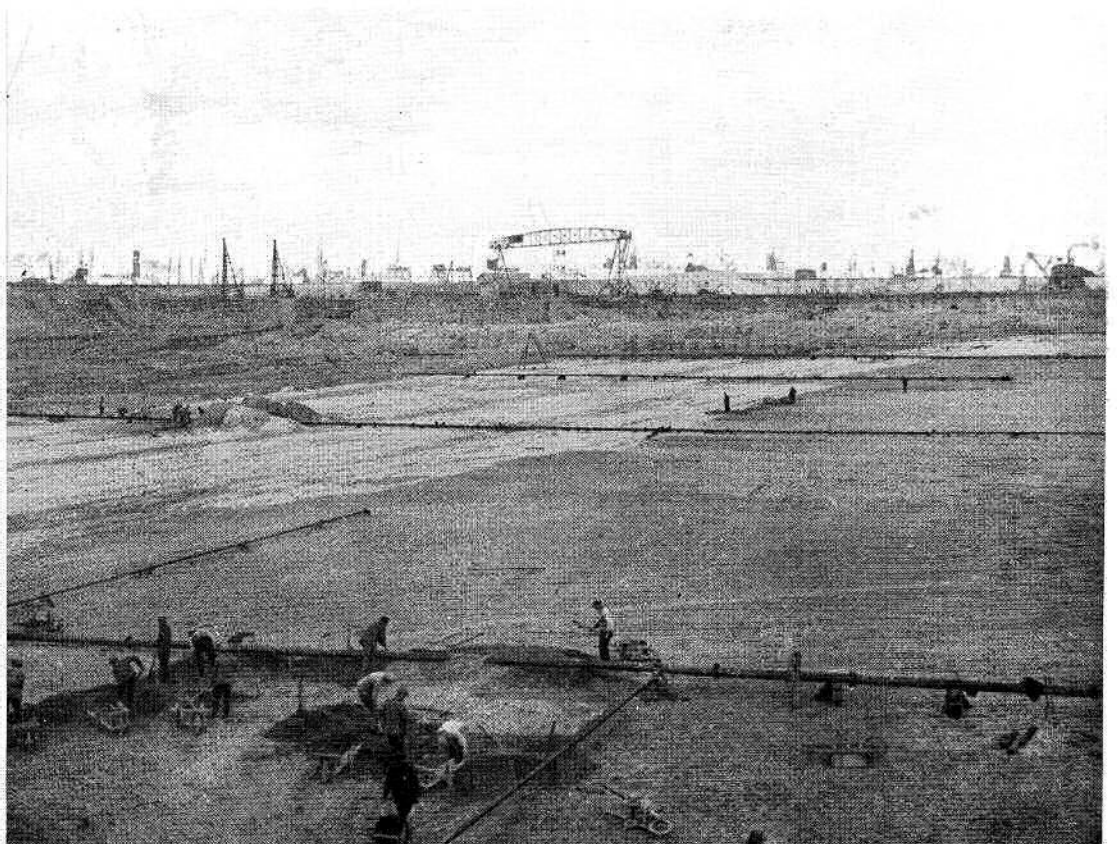
Anvers. — Construction de la quatrième Darse. Distributeur de béton. Antwerpen. — Bouwen van het vierde havendok. Betonverdel'er. Antwerp. — Construction of the 4th inner dock. Concrete belt conveyer.
