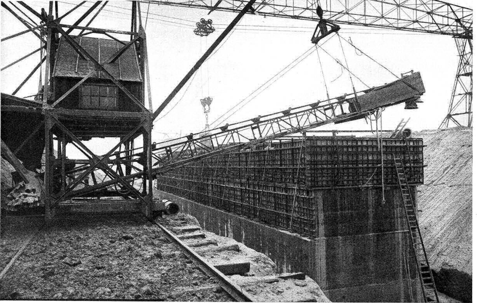
Anvers. — Construction de la quatrième Darse. Distributeur de béton. Antwerpen. — Bouwen van het vierde havendok. Betonverdel'er. Antwerp. — Construction of the 4th inner dock. Concrete belt conveyer.
