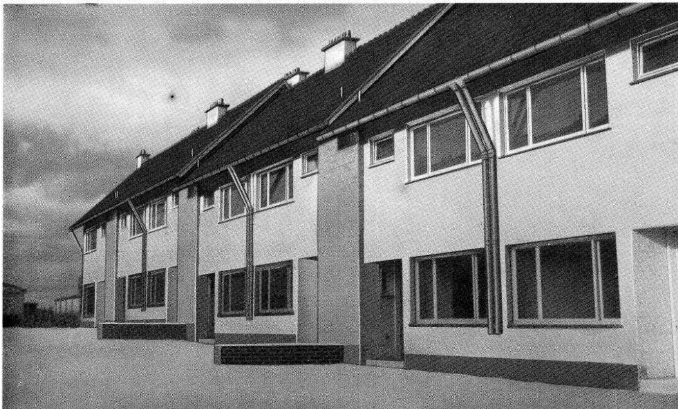
Ougrée. Quelques maisons terminées.
