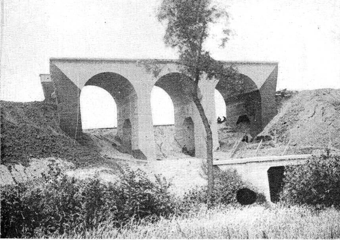
Chemin de fer Bruxelles-Gand. Pont sur le Bodembeek.
