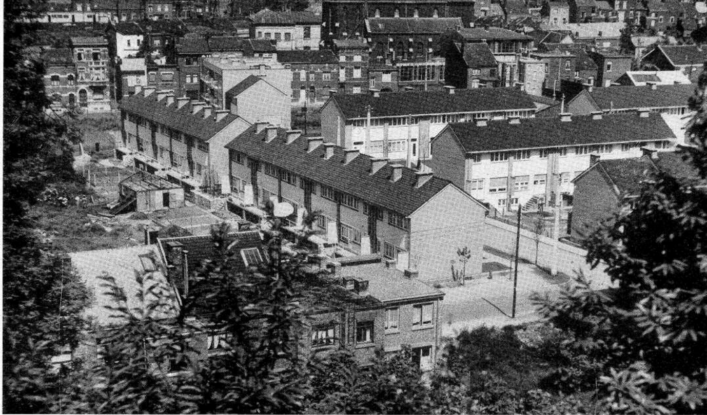
Angleur. Le chantier, Angleur. De werf. Angleur. The site.
