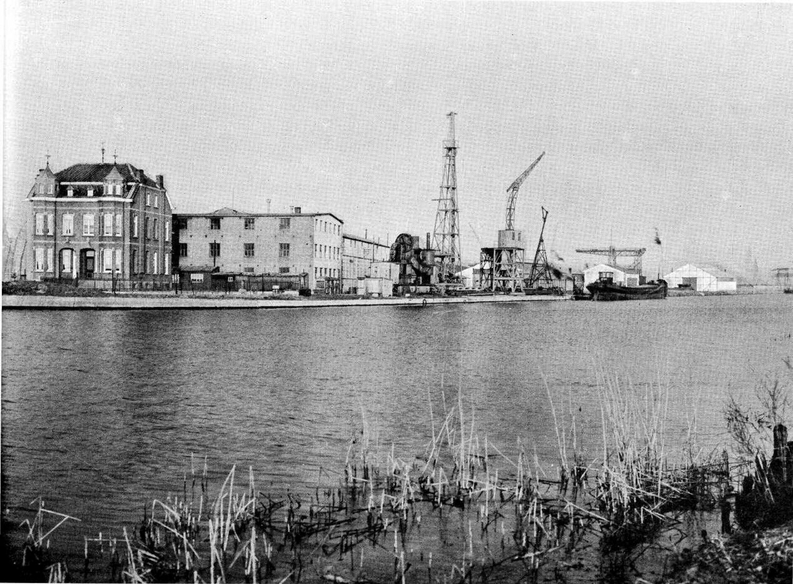
Petit-Willebroek. Vue générale du chantier « Daniel BODDEWIJN ».
