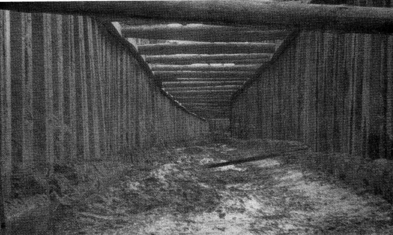
Charleroi. Travaux d'amélioration de la Sambre.
