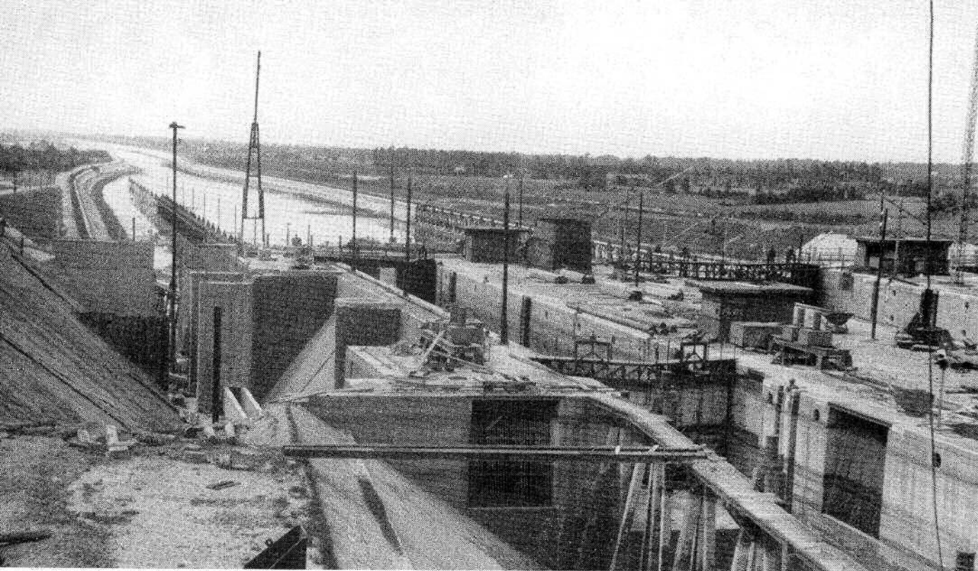
Travaux de réparation aux écluses de Diepenbeek.
