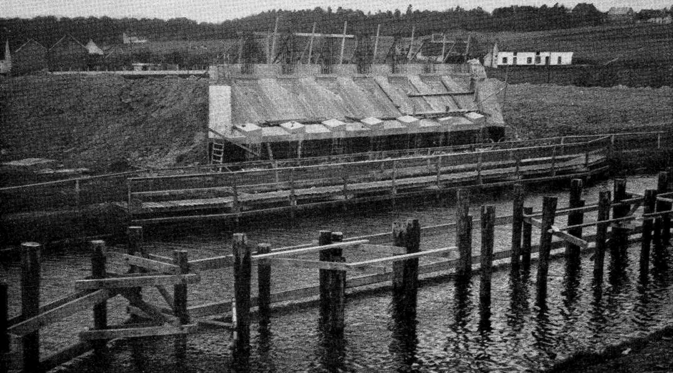
Canal Nimy-Blaton. Vue des culées achevées d'un pont en béton précontraint. Kanaal Nimy-Blaton. Voltooid landhoofden voor een brug in voorgespannen beton. Nimy-Blaton Canal. Abutments of a prestressed concrete bridge.
