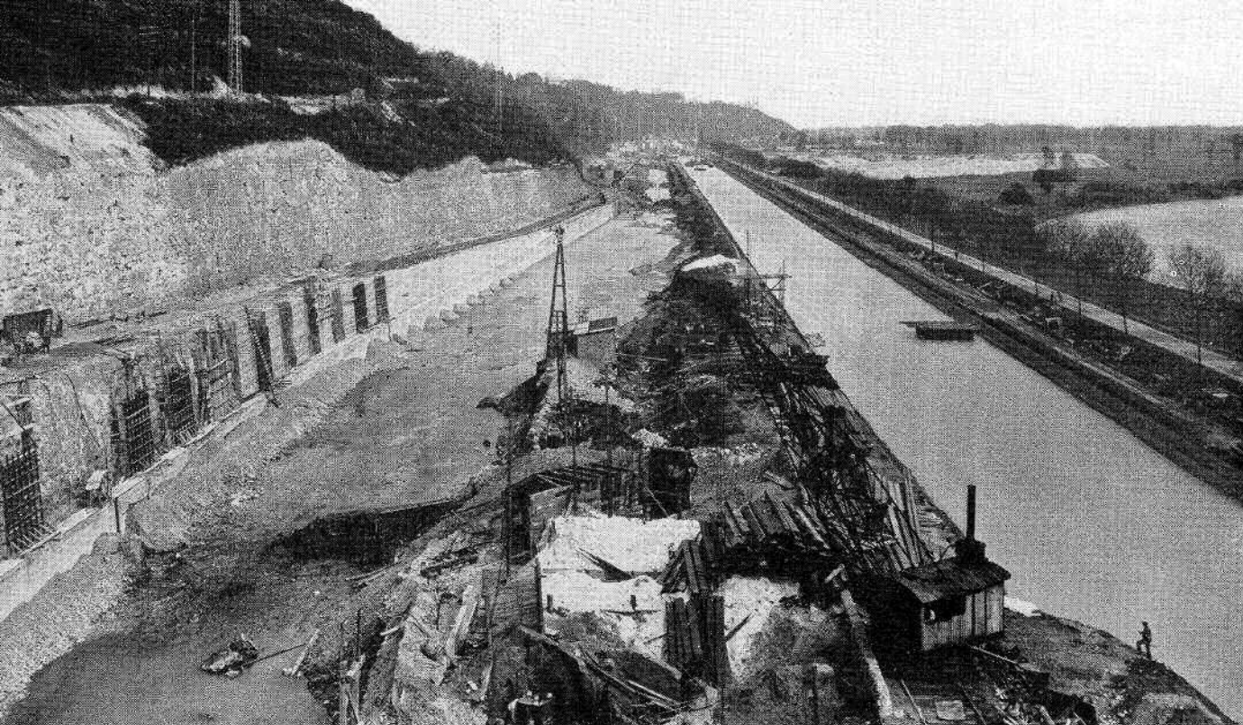
Canal Meuse-Escaut. Travaux de consolidation de la rive ouest à Lanaye.
