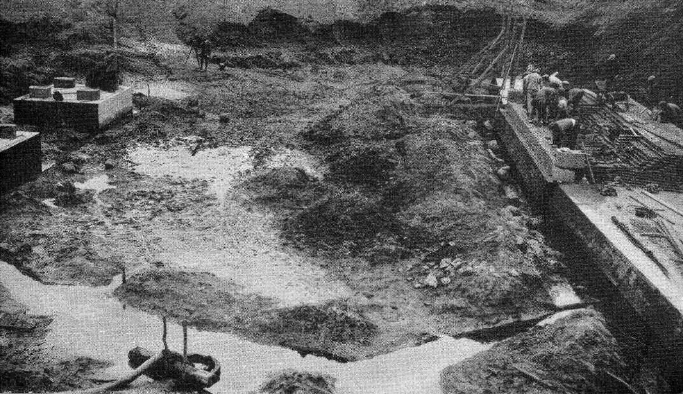
Section Olen-Oevel. Fondation du Pont de Hoogbuul.
