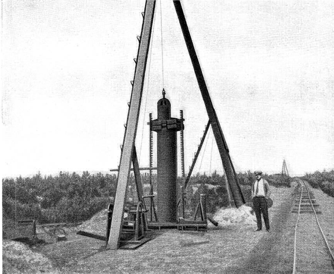
Lommel. Enlèvement du tubage d'un puits filtrant.
