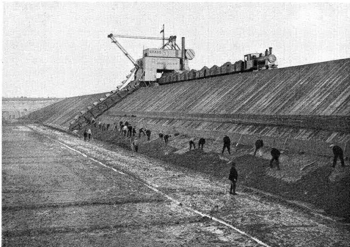
Anvers. — Construction de trois cales sèches. Vu de la cale A. Au fond l'excavateur entamant la fouille à proximité du bassin du Kattendijk.
