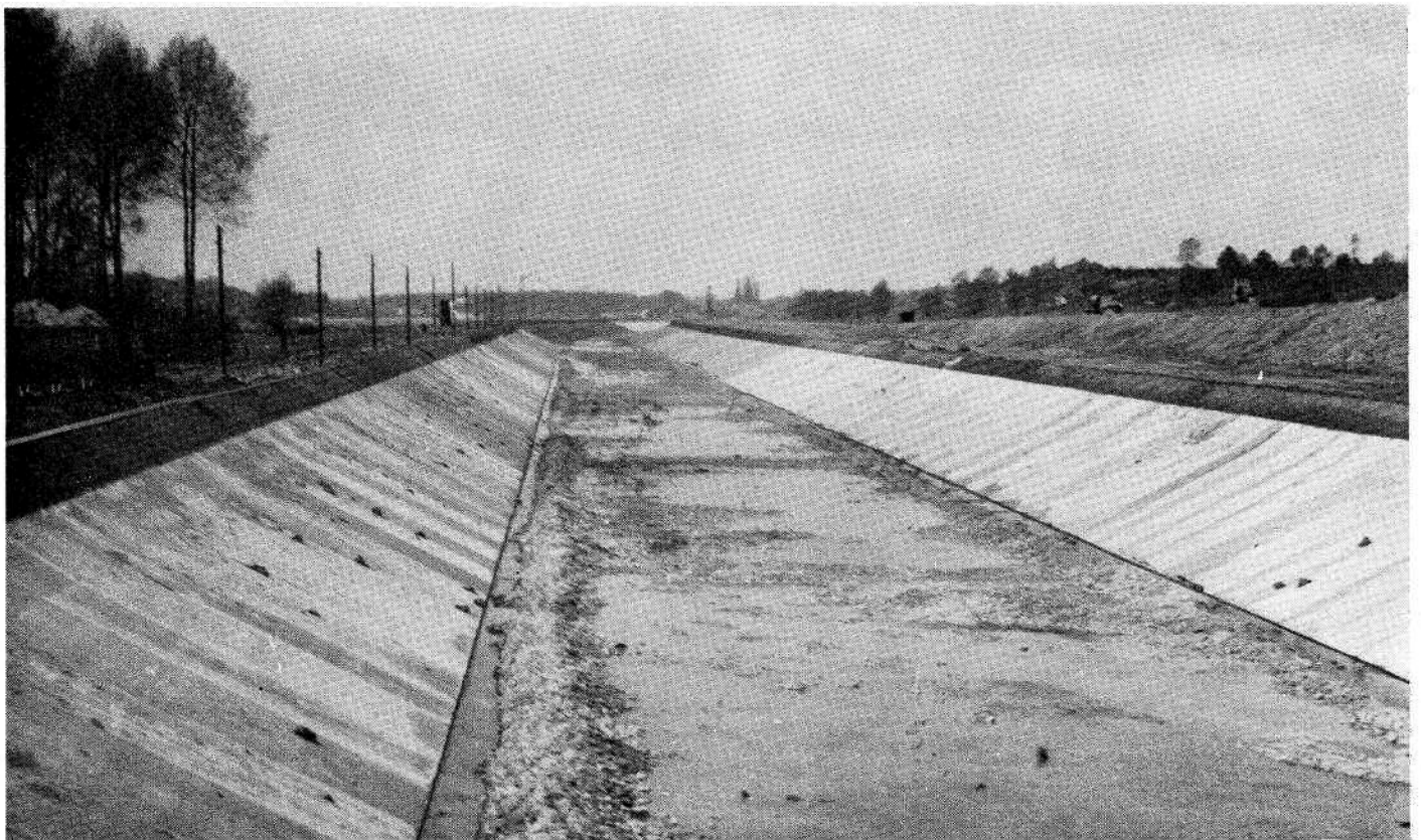
Canal Nimy-Blaton. Partie de canal achevée à l'aval du chemin du Risqu'à tout. Kanaal Nimy-Blaton. Voltooid kanaalgedeelte afwaarts de weg van Risqu'à tout. Nimy-Blaton Canal. Section of the finished canal downstream the Risqu'à tout road.
