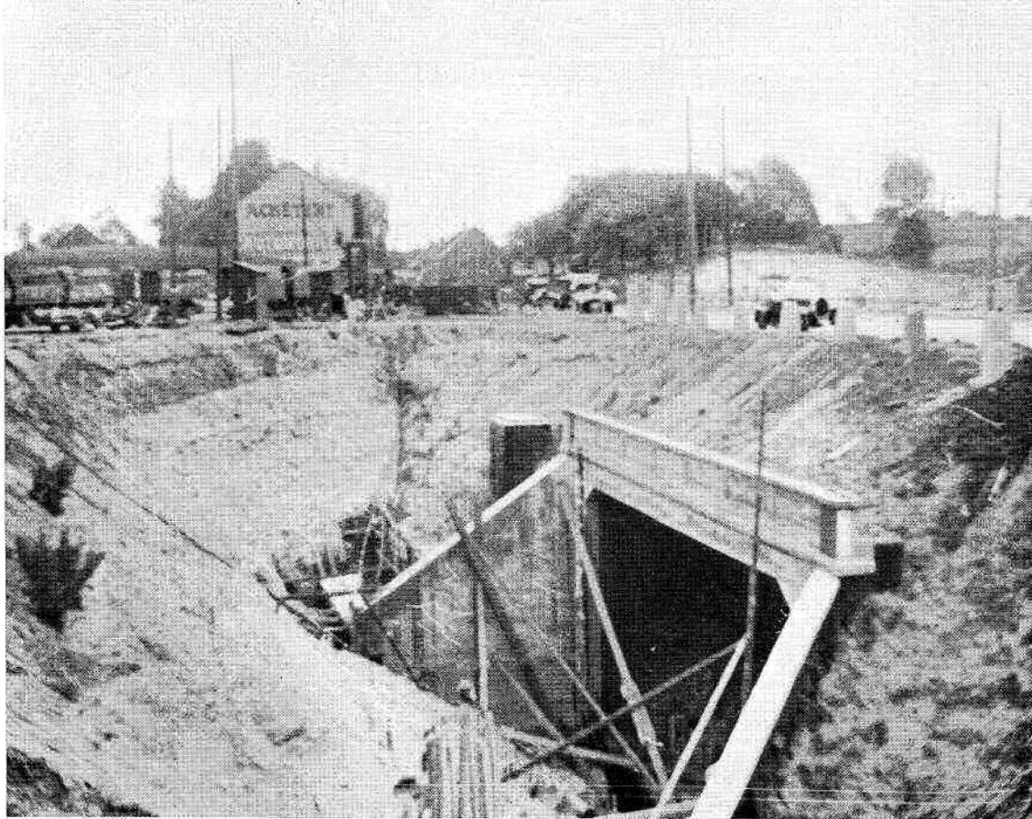
Chemin de fer Bruxelles-Gand. Tronçon de Schepdaal. Pont- tube en béton armé sous la chaussée de Ninove.
